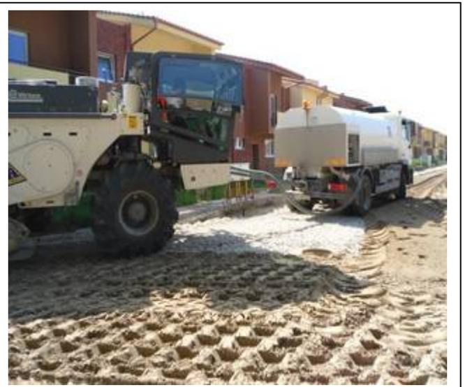
**TERRA-3000®** - Arbeitslösung in das Planum mittels Spezialfräse einmischen
